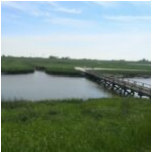
Steg Langwarder Groden
